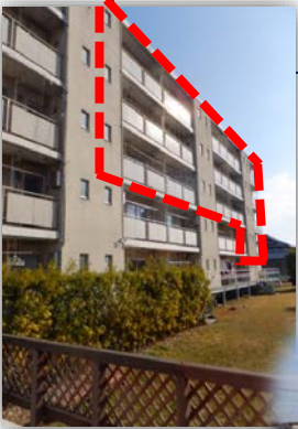
--- 工事改修部分
